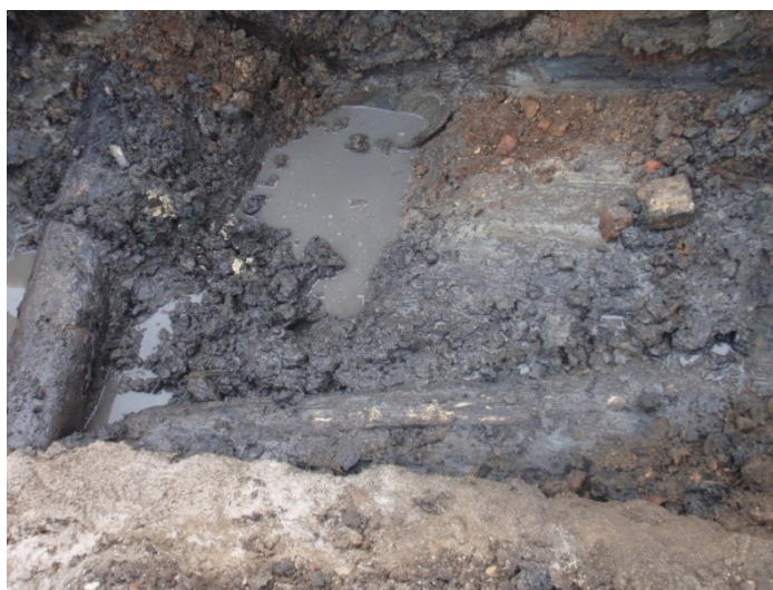
Foto. 10 Dwie drewniane rury wodociągowe. Widok w czasie eksploracji.
