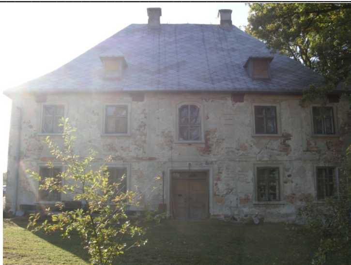
Foto. 15 Budynek Dawnej Plebanii w Broniszowie
